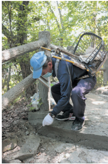
登山者の安全のため、新たにセメントで階段を作る
