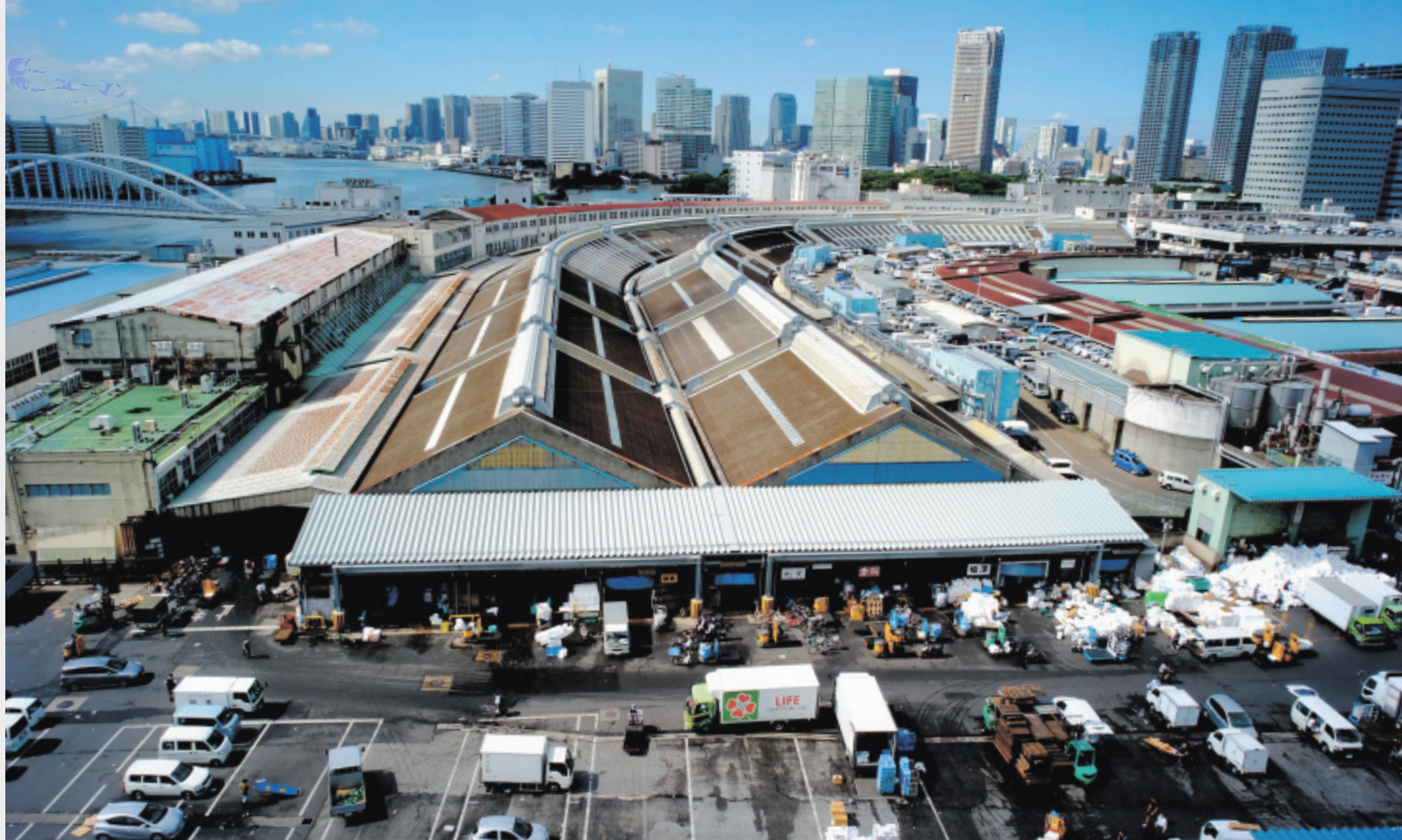
かつて貨物線の駅でもあった築地市場。列車は写真右奥へと続いていた支線を通って、漁船は写真左上から隅田川を遡って、全国の魚を運んできた。ホームでの積み下ろしを効率化するため、市場全体がカーブを描くように設計されている
